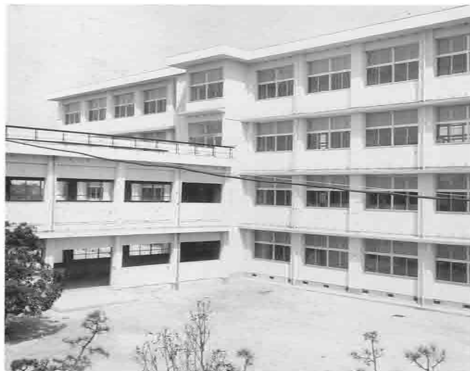
ホームルーム棟16教室落成(昭和45年) 全面改築第一期工事
