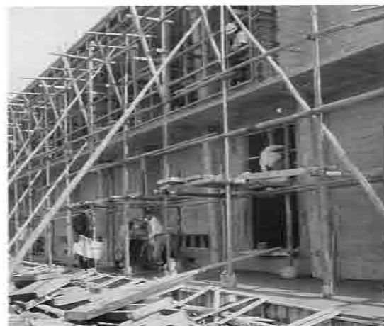
産業館工事中
