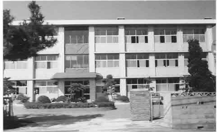
完成した管理棟
