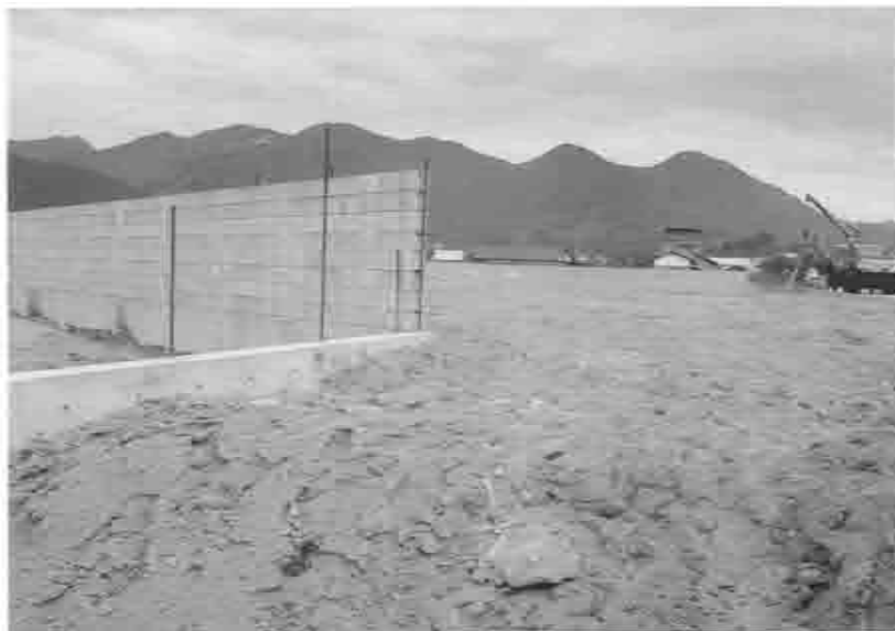
グラウンド拡張工事(昭和53年)
