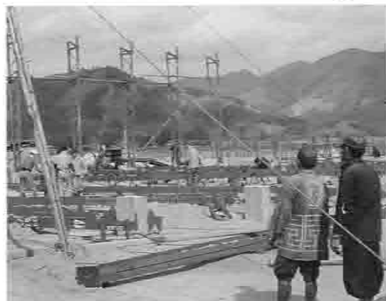
産業館工事中
