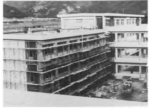
金属工業科実習棟落成(昭和49年)
