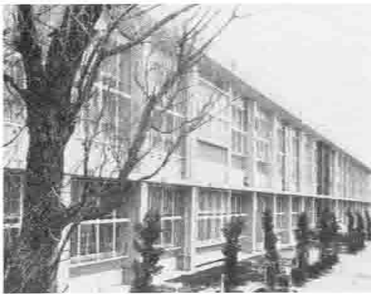
機械科実習棟落成(昭和47年)
